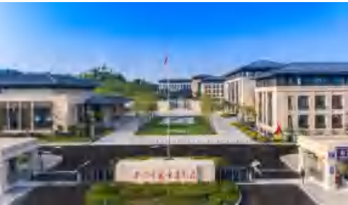
宜昌市委党校：2016年宜昌市工程建设管理暨绿色施工观摩工程
